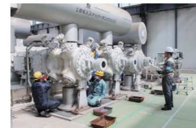
ガス圧縮機のメンテナンス
