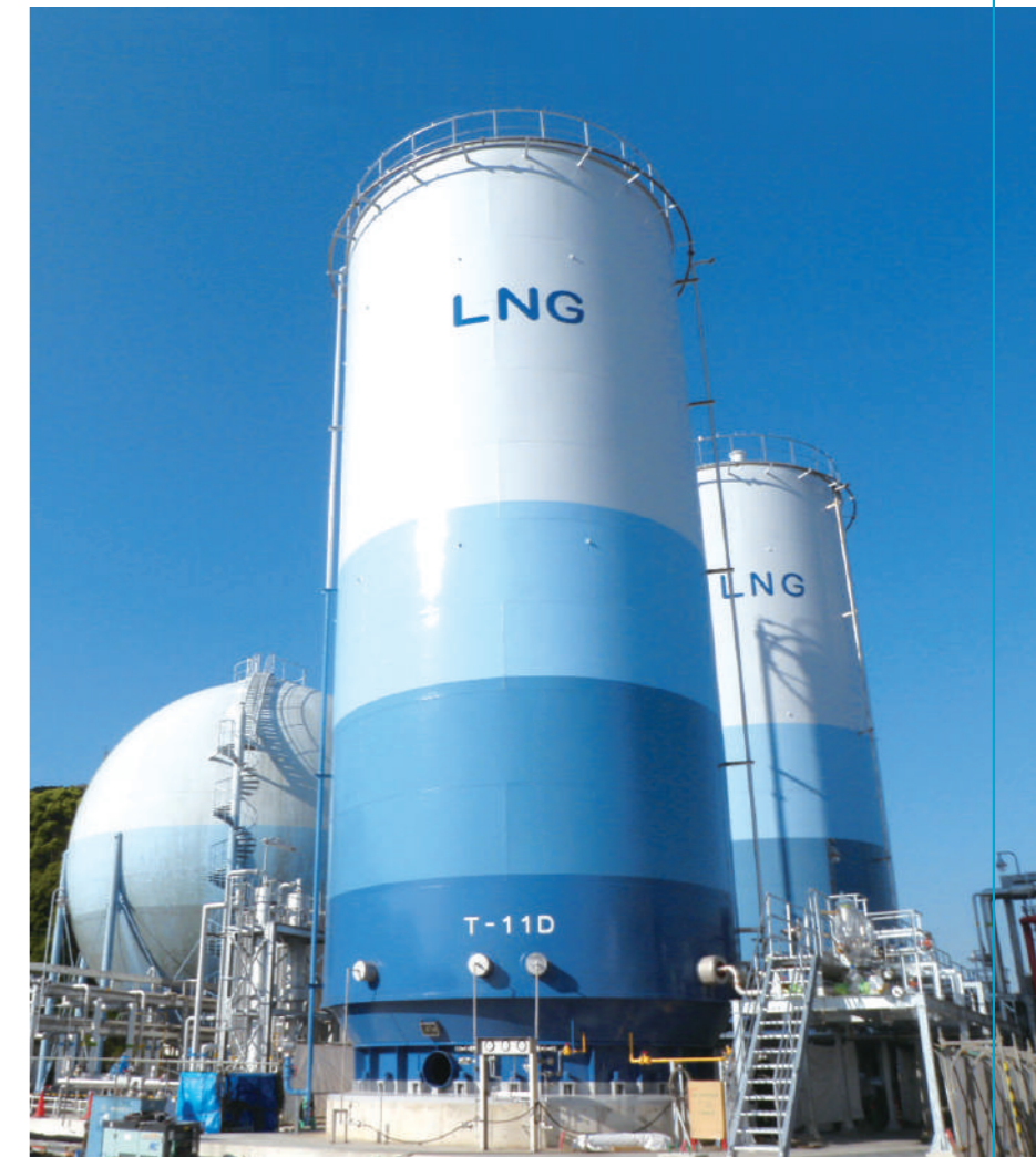
LNGサテライト基地
