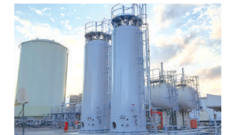
原料低熱量化対策工事
