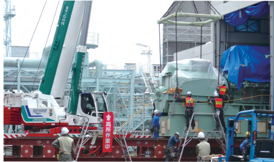
コージェネレーション設備建設工事
